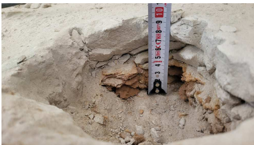
Odkrywa warstw posadzkowych.
