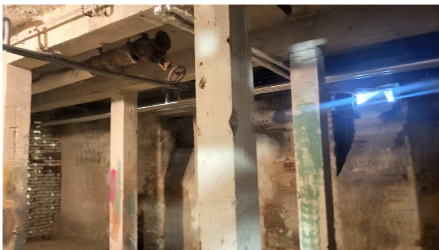
Podpiwniczenie – konstrukcja główna żelbetowa monolityczna, ściany murowane.
