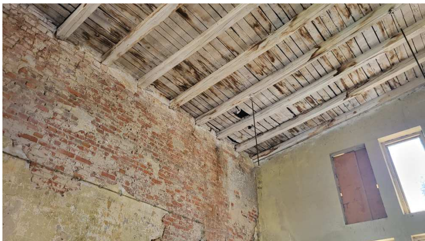
Budynek garażowy – drewniana konstrukcja dachu, ściany murowane z cegły ceramicznej pełnej
