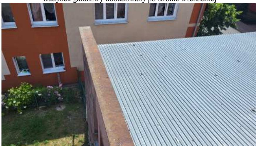
Budynek garażowy – pokrycie dachu blacha trapezową
