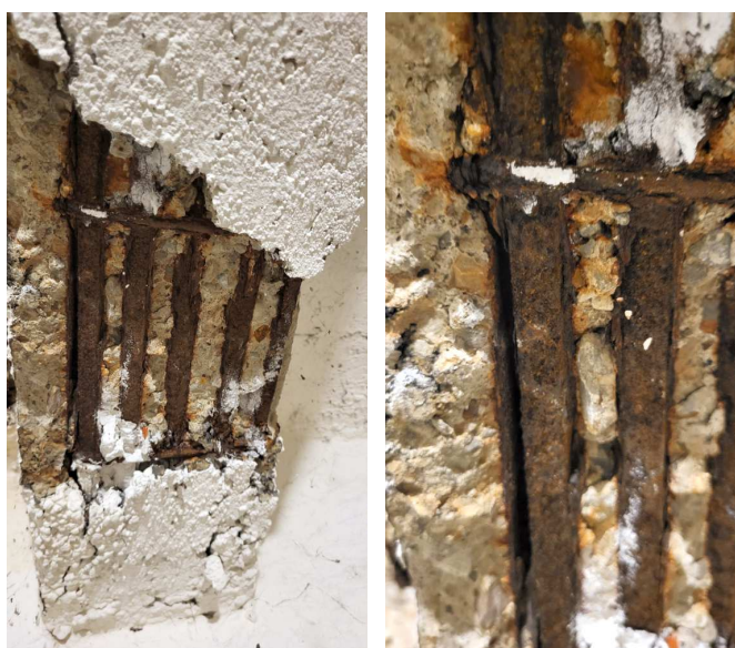
Podpiwniczenie – korozja zbrojenia belek żelbetowych.
