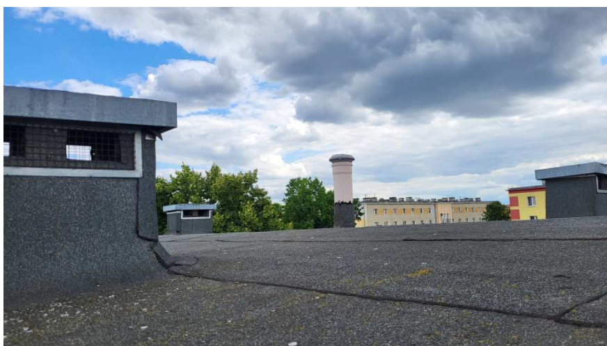
Budynek „kotłowni” – konstrukcja stropodachu wentylowanego z pokryciem papą
