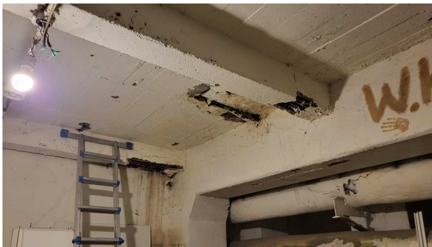
Podpiwniczenie – korozja elementów żelbetowych.
